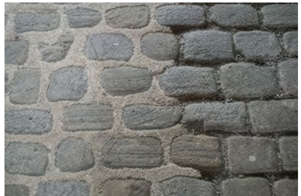
Kopfsteinpflaster ist schwer begeh- und berollbar. Abgeschliffene Steine und enge Fugen machen die Straßenüberquerung leichter.
